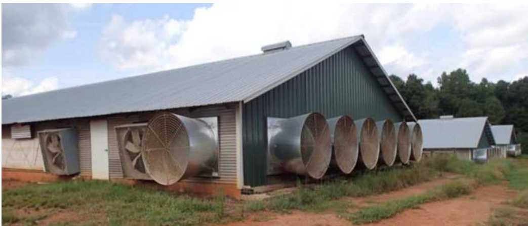
Figure 61. Edificio per il ricovero di tacchini con ventilazione forzata (Foto estratta dal documento BAT Conclusions 2015)
