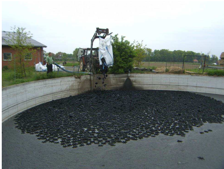
Figura 7. Operazione di caricamento di piastrelle di plastica geometrica nella vasca di stoccaggio del liquame (Hexa-Cover)*
